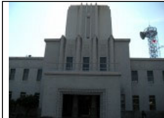
合同庁舎 外観
