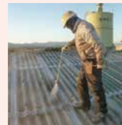
プライマー塗布
