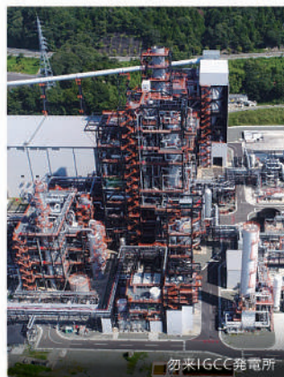
勿来IGCC発電所
